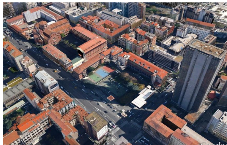
FIG. 3.2.1.46 Il grande vuoto tra via M. Gioia e via Galvani
