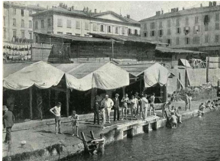
FIG. 3.2.1.20 I bagni provvisori al Ponte delle Gabelle (1887) sullo sfondo la Stazione Miano-Monza
